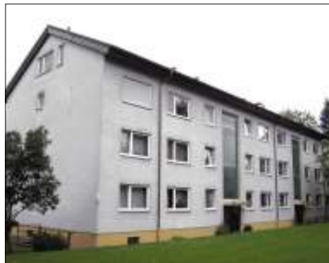
Ein Bild aus vergangenen Tagen: Dieses 12-Familien-Wohnhaus in der Wiesenstraße wurde in drei Bauabschnitten komplett saniert.
