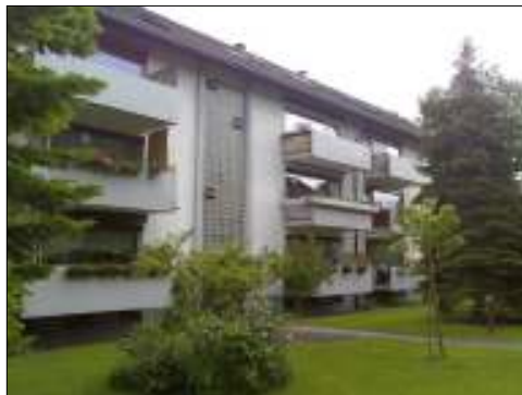
Die Wohnanlage in der Frankenstraße vor der Sanierung.
