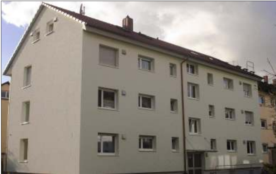
Das komplett sanierte Mehrfamilienhaus in der Richard-Wagner-Straße.
