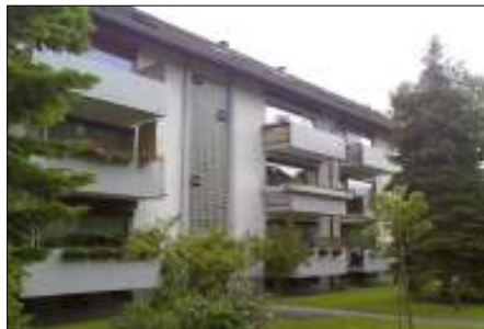
Die Wohnanlage in der Frankenstraße vor der Sanierung.
